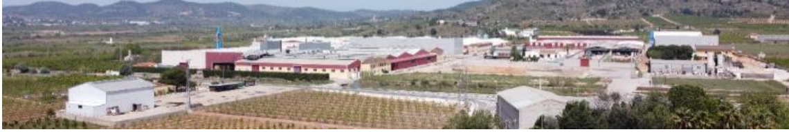
Foto 2 Zona industrial más próxima al ámbito del proyecto.
